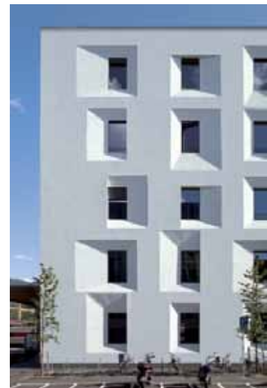
Das Prinzip des Lichtkeils inspirierte den Architekten Michael Tribus beim Umbau eines ehemaligen Postgebäudes in Bozen. © René Riller, Schlanders, IT
