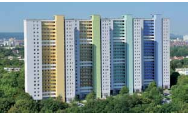
Die Wohnungswirtschaft ist eine treibende Kraft der Energiewende. Dank ihrer vielen energetisch sanierten Liegenschaften – wie hier beim Stuttgarter Julius-Brecht-Hochhaus – trägt sie bereits heute erheblich dazu bei, die Klimaziele Deutschlands zu erreichen. © Isabell Munck, Stuttgart, DE
